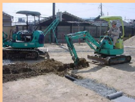
機械でみぞをほり、パイプをうめて排水せつびをつくります。
